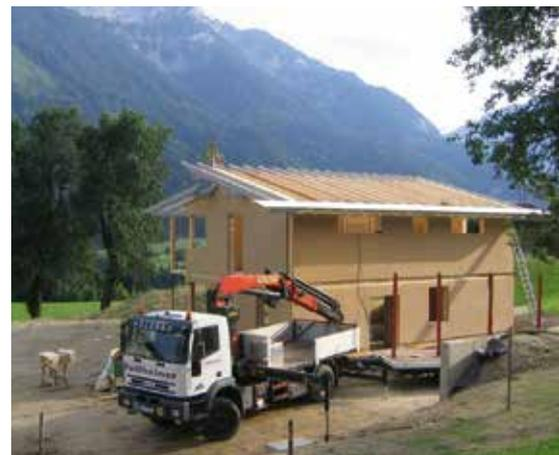
Der Aufbau eines Faltheiner Holzbau-Fertigteilhauses erfolgt mit dem betriebseigenen Autokran
